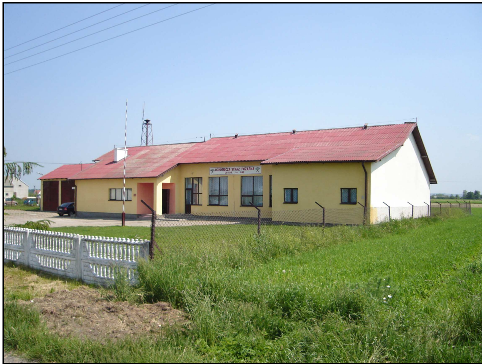
Ryc. 5. Siedziba OSP w Długiem w budynku gminnym w ramach którego powstanie świetlica wiejska (fot. P. Dahlke)
